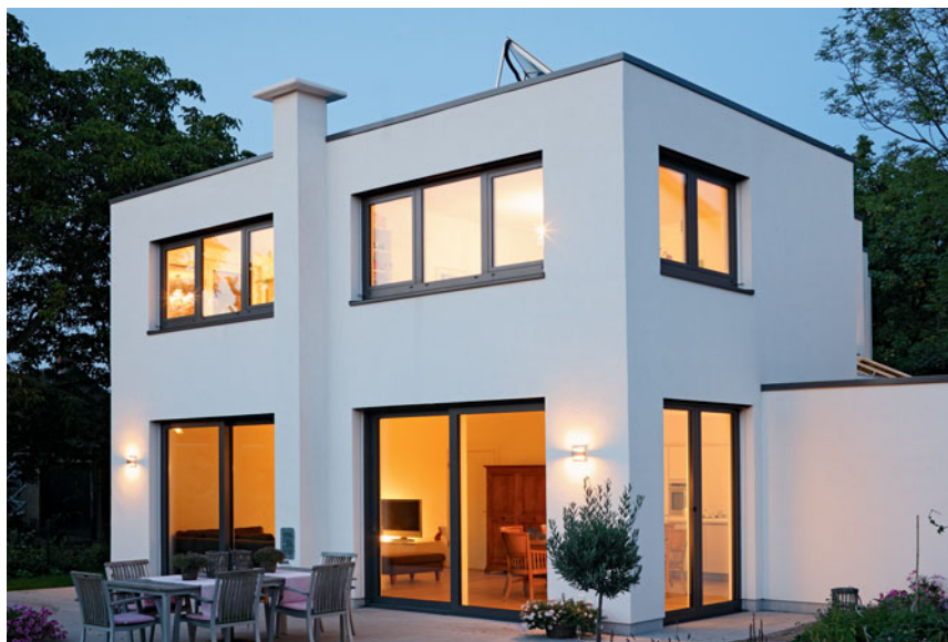
Okna w budynku poddanym modernizacji
